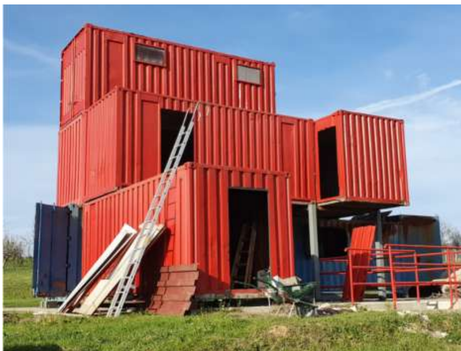
Slika 7. Poligon požarna kuća i simulator plamenih udara u izgradnji u Našicama
